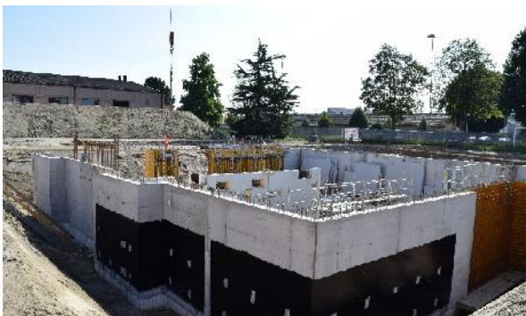
Photo : juillet 2020 construction du sous-sol.
