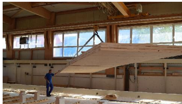
Photo : septembre 2020 construction des structures bois.
